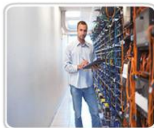
Se deben verificar las instalaciones para detectar cualquier daño.
