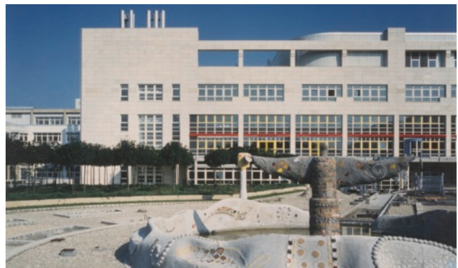
Automatización de edificios
